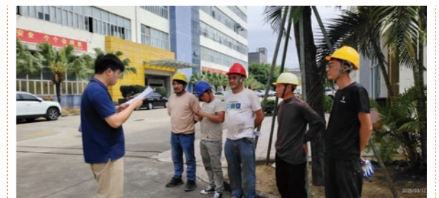
长园电力无尘车间升级改造安全交底
